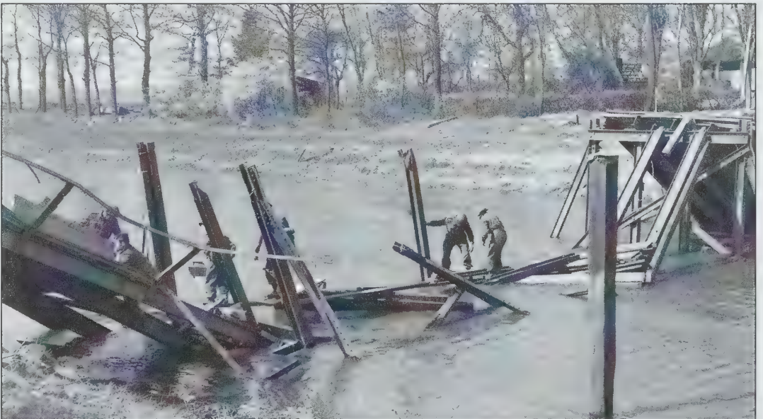
MANNEN VAN DE BLACK WATCH BOUWEN EEN PROVISORISCHE BRUG OVER DE REGGE BIJ OMMEN. (OPENBARE ARCHIEVEN CANADA 49639)
