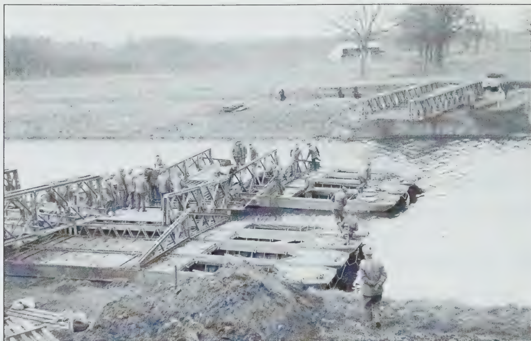
DES INGÉNIEURS DE LA 4 E DIVISION CONSTRUISANT UN PONT BAILEY SUR LE CANAL TWENTE À DELDEN. (ARCHIVES NATIONALES DU CANADA 49159)
