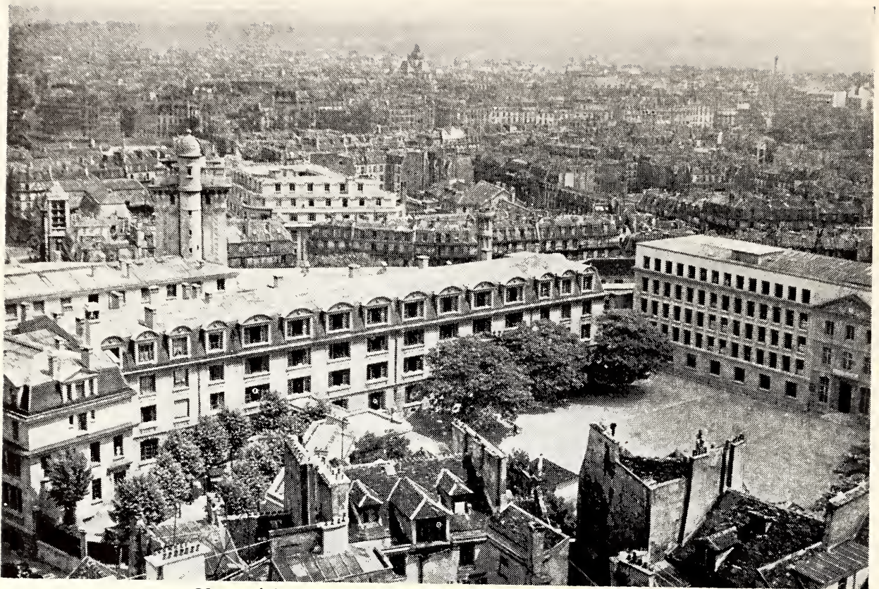
Vue aérienne (partielle) de l'École Polytechnique.
