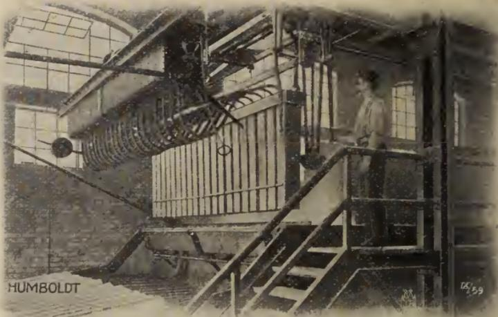
Eisgenerator für Blockeisfabrikation.
