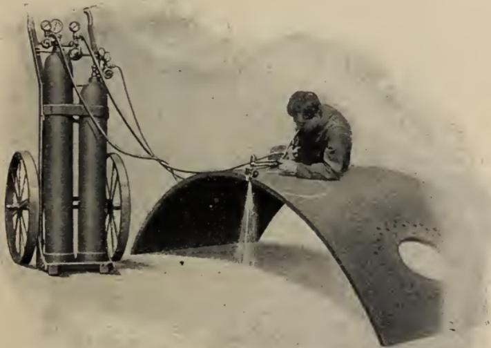
Fig. 3. Schneiden eines Kesselbleches mit dem Handschneidapparat.
