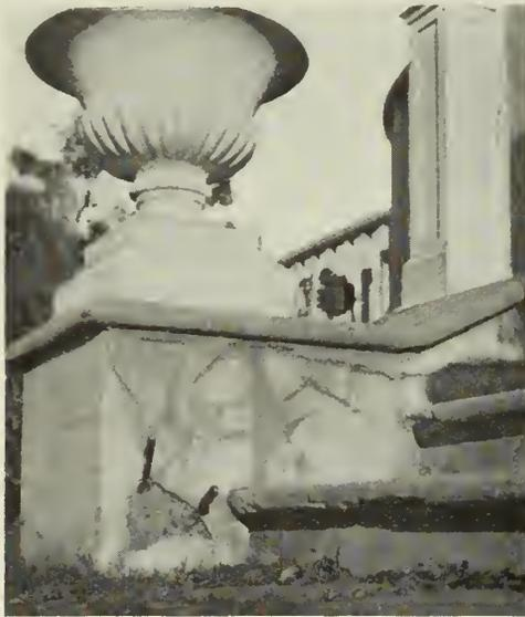
Fig. 6—Failure due to Inferior Aggregate.
