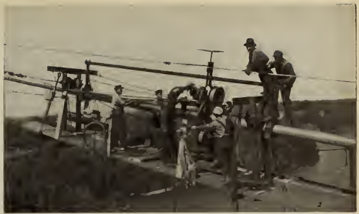
Fig. 8—Machine Wrapping the Cable
