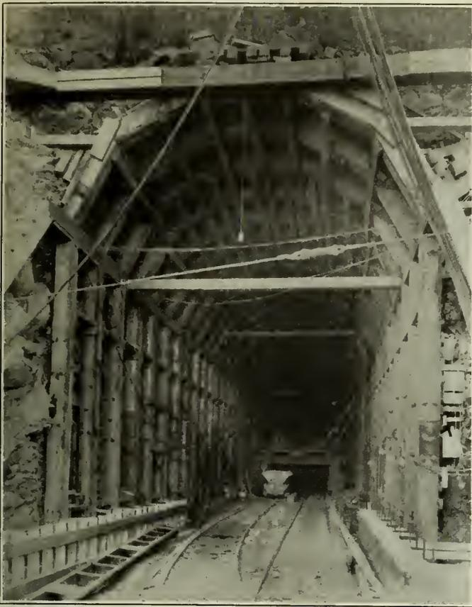
Fig. 4—Timber Lining, North Portal.
