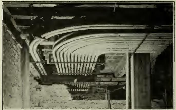
Fig. 4—Feeder Conduit to Shaft E.
