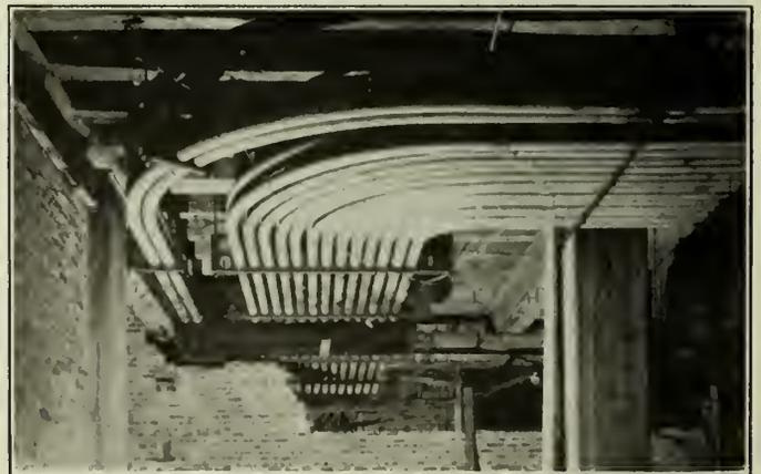
Fig. 4—Feeder Conduit to Shaft E.
