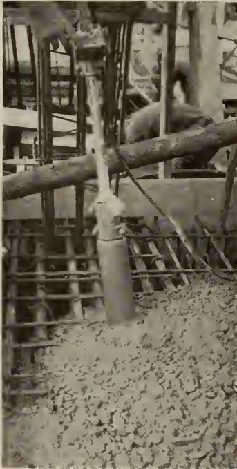
Fig. 20—Concrete Vibrator.
