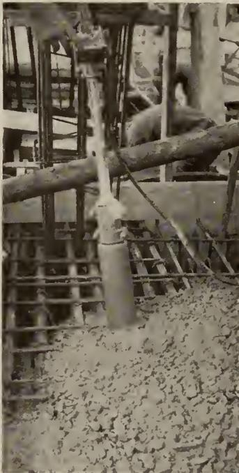
Fig. 20—Concrete Vibrator.
